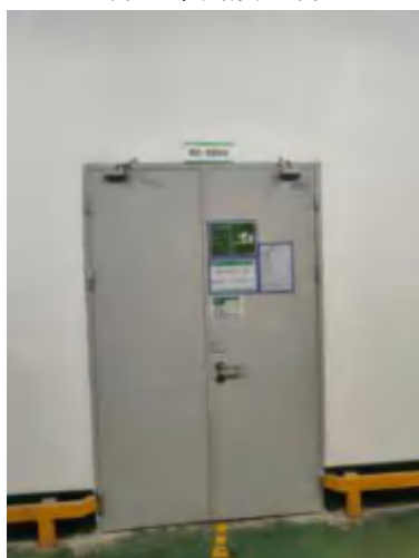
加弹车间一般工业固废暂存场
