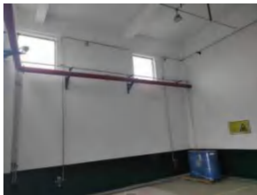
危废仓库内部
